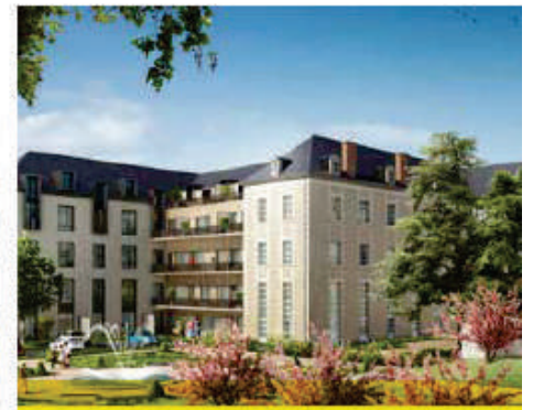
Maison de la Trinite • Poitiers • En construction
